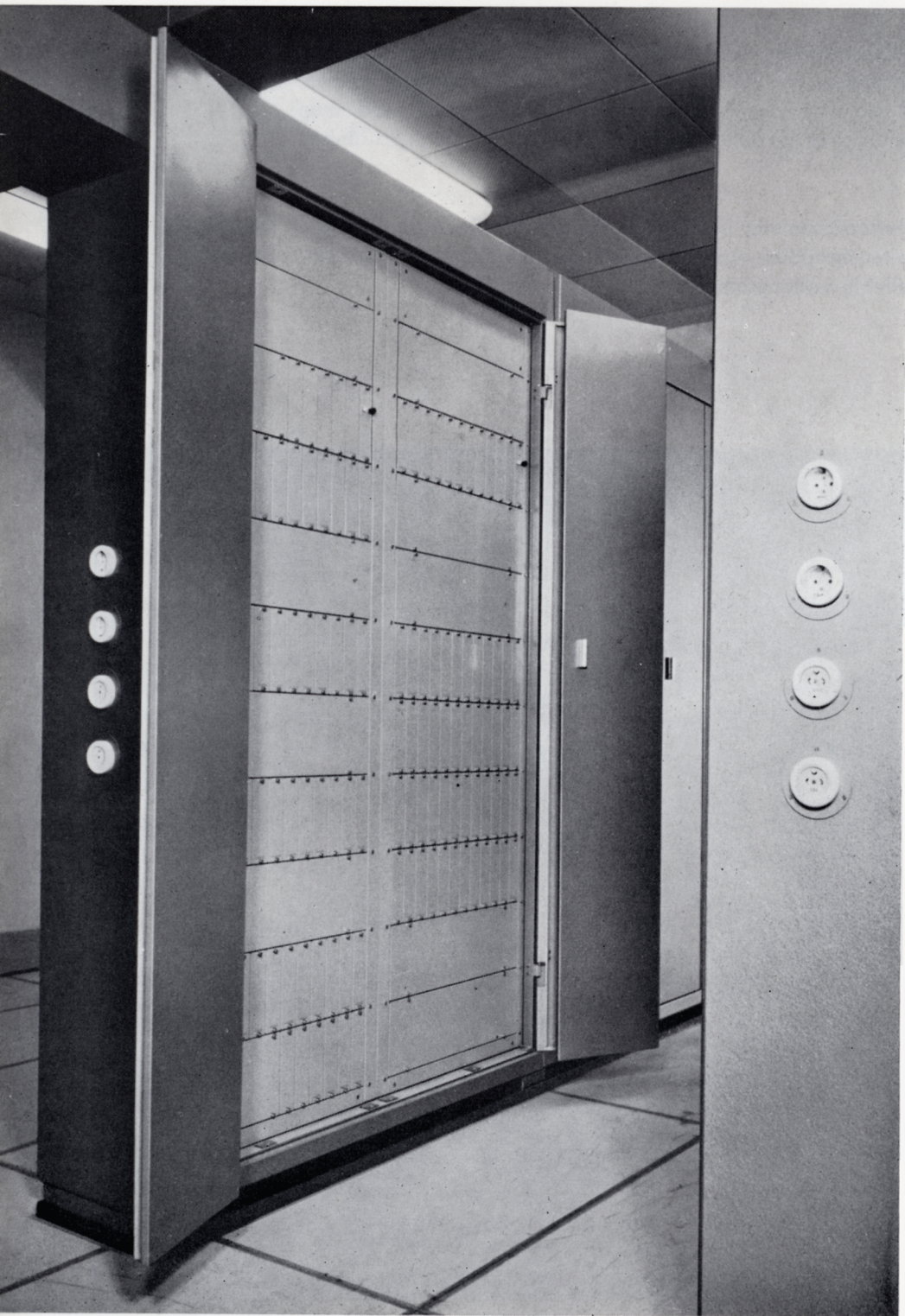
Geöffneter Schrank mit zwei Gestellen und Steckeinheiten
